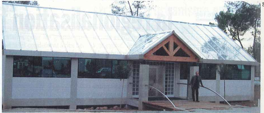
La toiture du bâtiment est réalisée en Inox collé sur des panneaux traditionnels.
